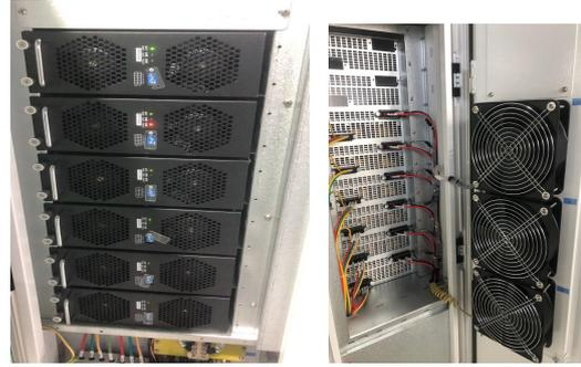
图 3-2 打开侧门检查进出风口积尘
