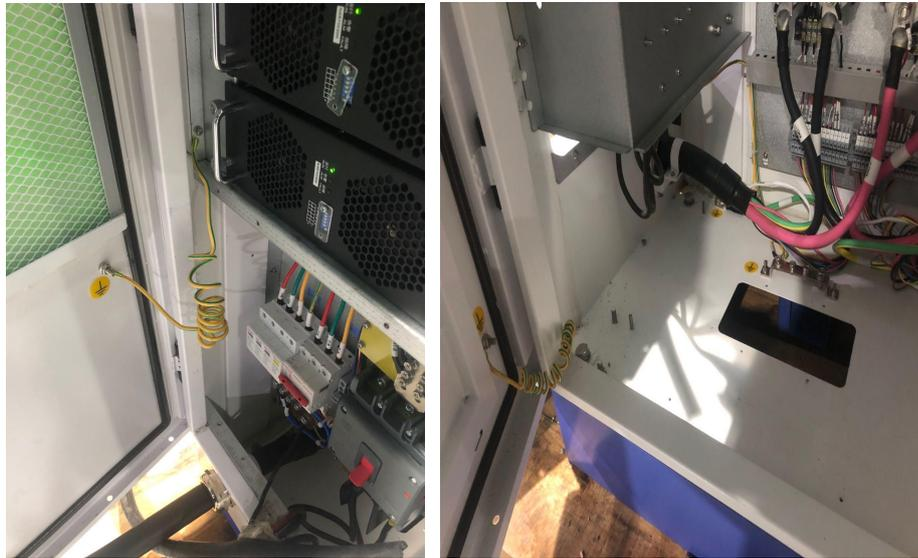
图 3-3 检查接地螺柱的螺帽是否松动
