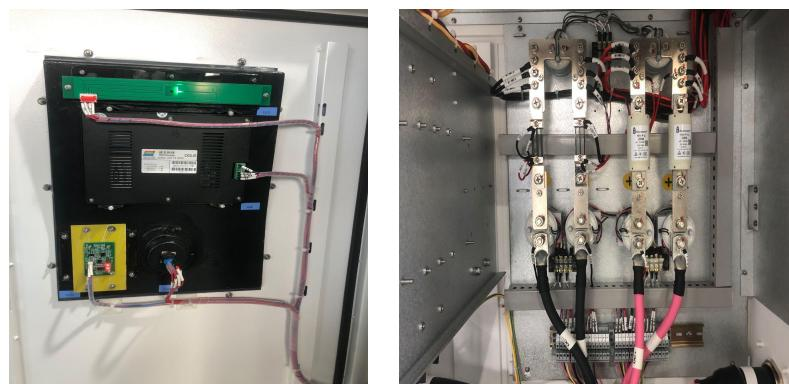
图 3-7 检查充电连接线及缠绕管的老化、磨损情况
